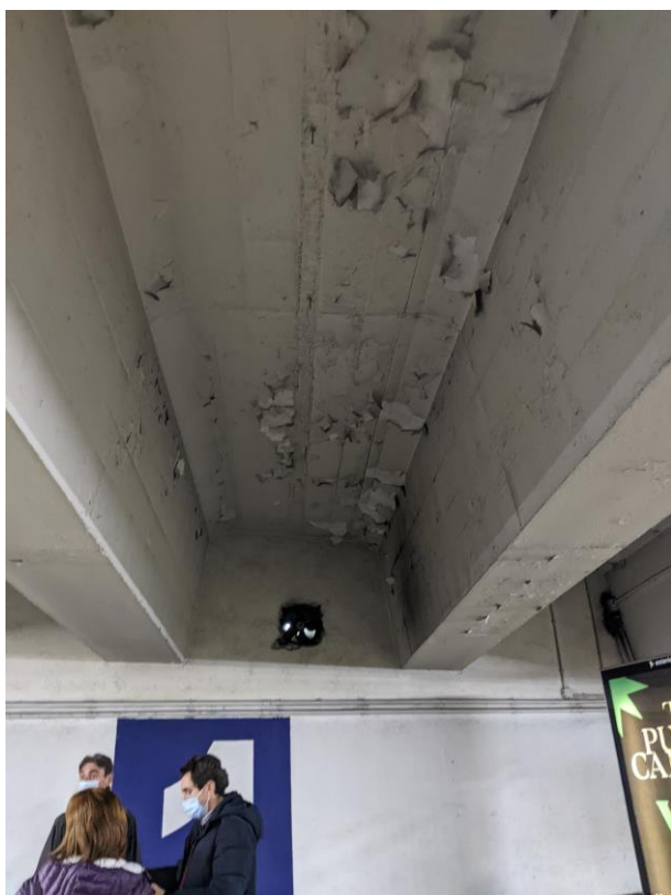
Foto 33. Humedades en cubierta núcleo rampa
