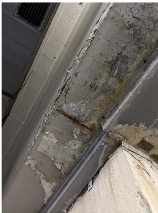
Foto 9. Estado de la fibra inferior de la viga de cubierta adyacente a JD2
