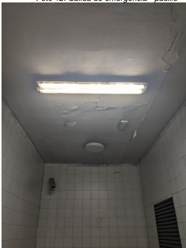
Foto 14. Salida de emergencia – humedad en pared
