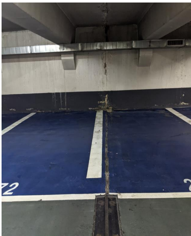
Foto 27. Junta deteriorada en pavimento y muro
