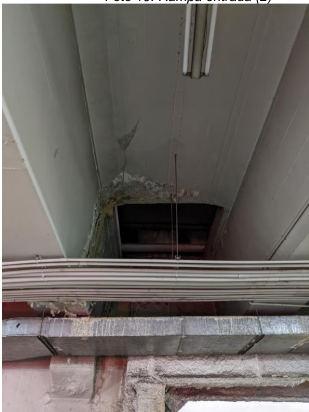
Foto 21. Agujero en losa de cubierta 1
