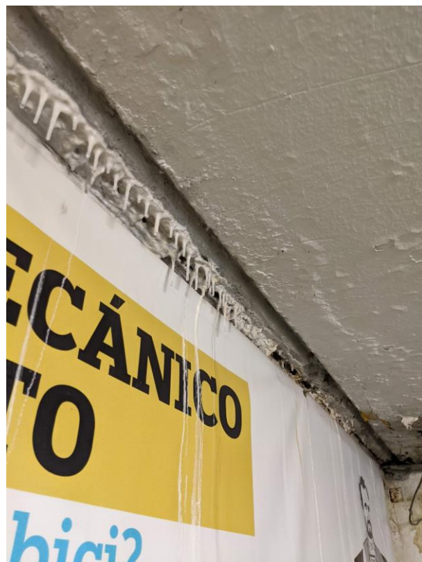
Foto 40. Filtraciones en losa de cubierta de rampa
