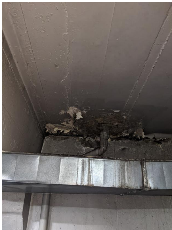
Foto 10. Humedades en junta tubería
