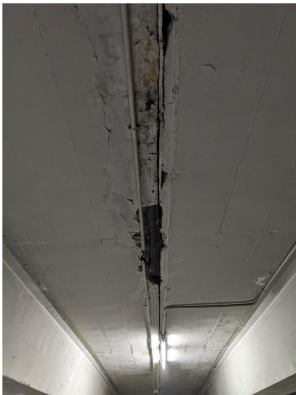
Foto 21. Pérdida de recubrimiento en junta con vista de la junta
