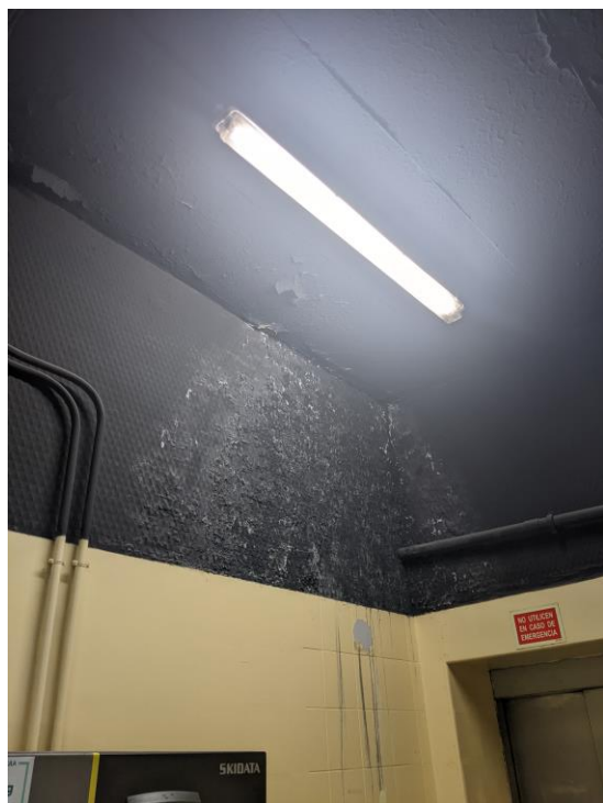
Foto 3. Humedades pared sala ascensores
