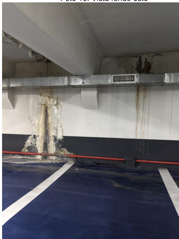
Foto 12. Junta de dilatación en muro (2)
