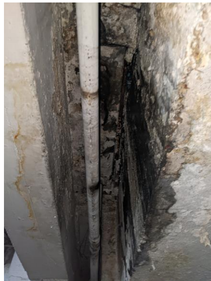
Foto 20. Filtraciones en forjado – encuentro rampa (bajo taller bicis)
