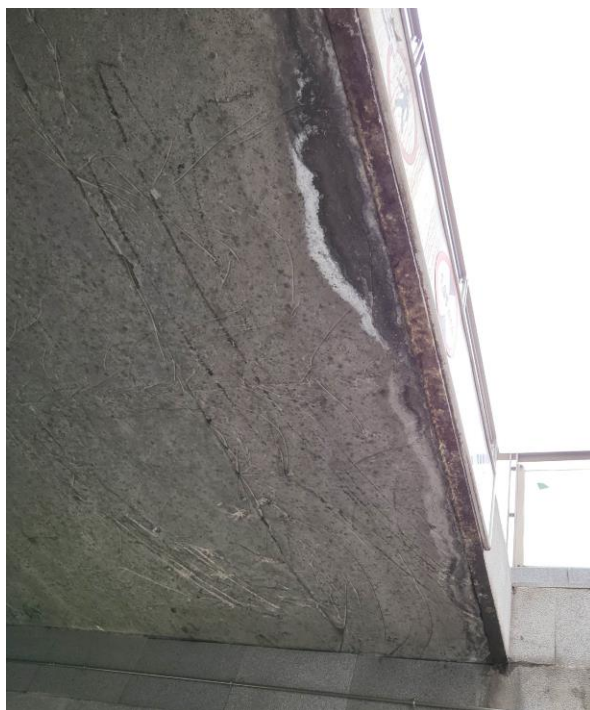
Foto 29. Pérdida de recubrimiento de hormigón en losa de cubierta de rampa
