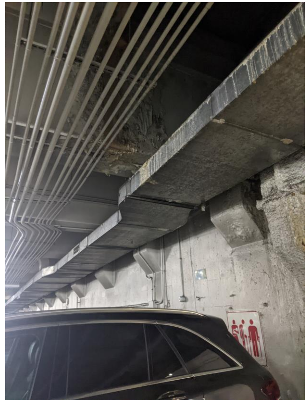
Foto 24. Humedades viga (zona rampa)
