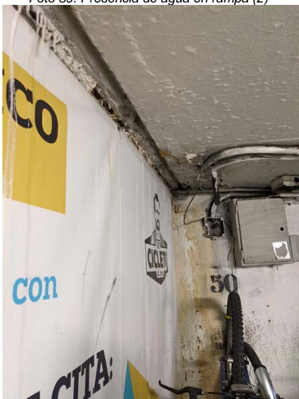
Foto 41. Filtraciones en cubierta y muro rampa
