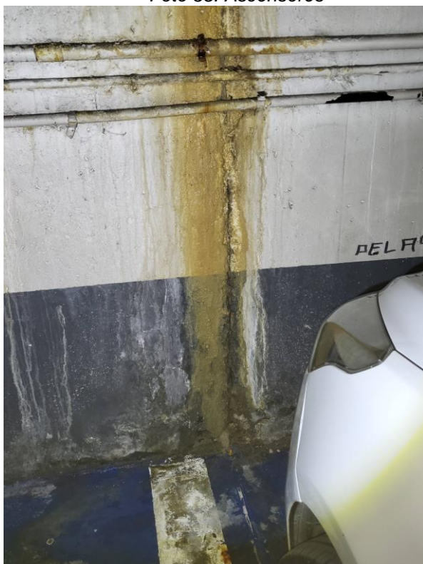
Foto 37. Junta de dilatación 2: filtraciones
