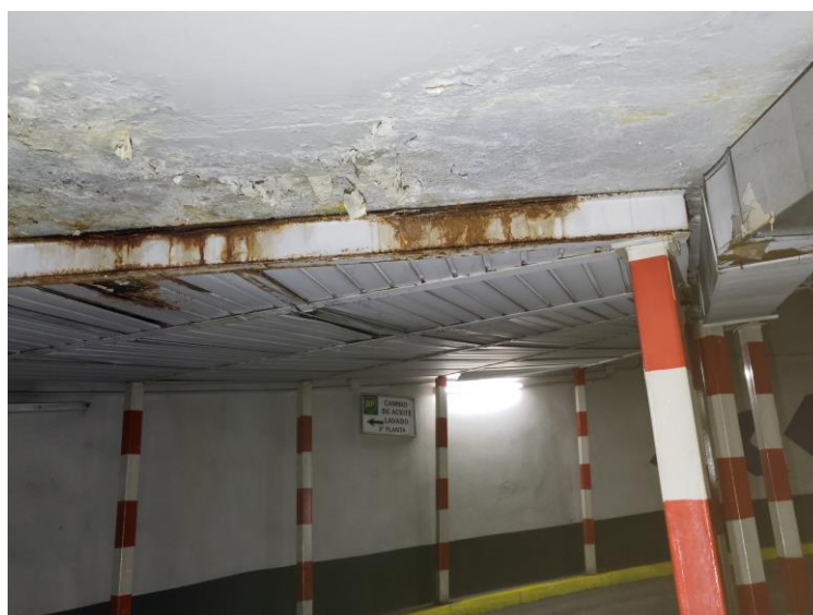
Foto 18. Viga dintel metálica oxidada rampa baja a P-3
