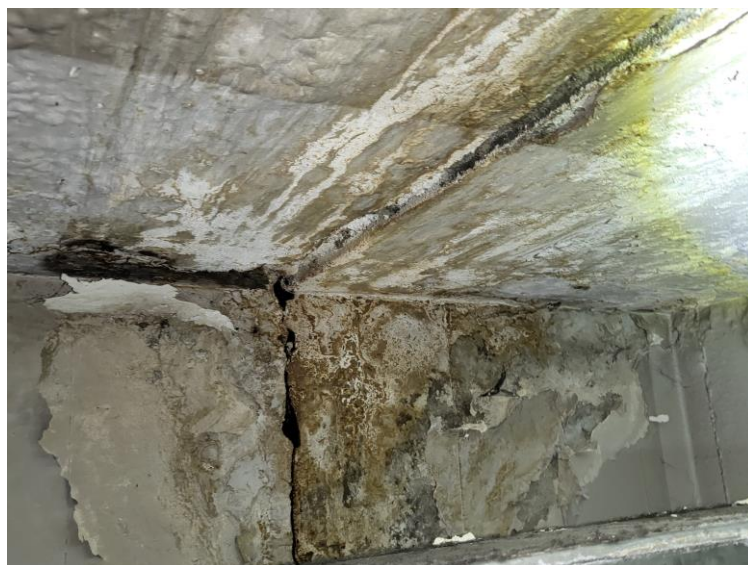
Foto 13. Humedades en espacio entre pilar y pantalla
