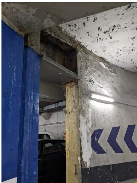
Foto 11. Junta en pantallas vista interior
