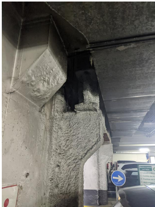
Foto 7. Apoyo de la viga dintel de entrada
