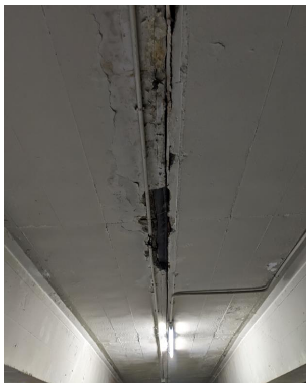
Foto 28. Junta en forjado deteriorada, vista del aparato de junta (P-2)
