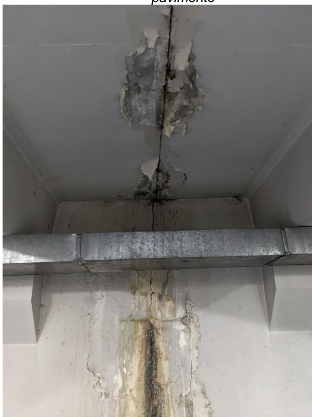
Foto 15. Junta de dilatación -muro y forjado-
