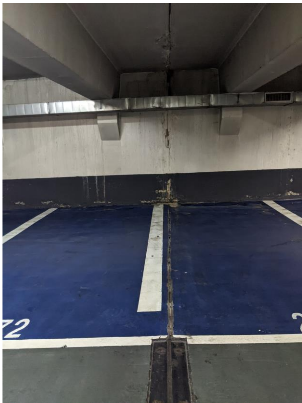
Foto 2. Apoyo de las vigas de forjado en vigas de gran canto
