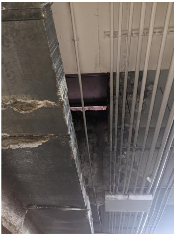
Foto 13. Humedades en forjado de cubierta, zona rampa
