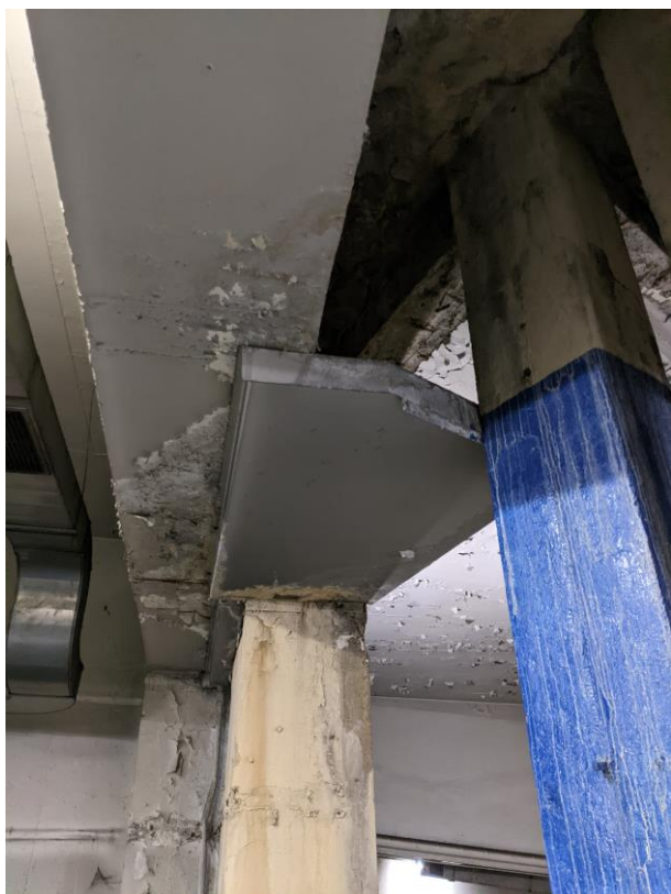
Foto 8. Filtraciones de agua en zona entre juntas – planta P1
