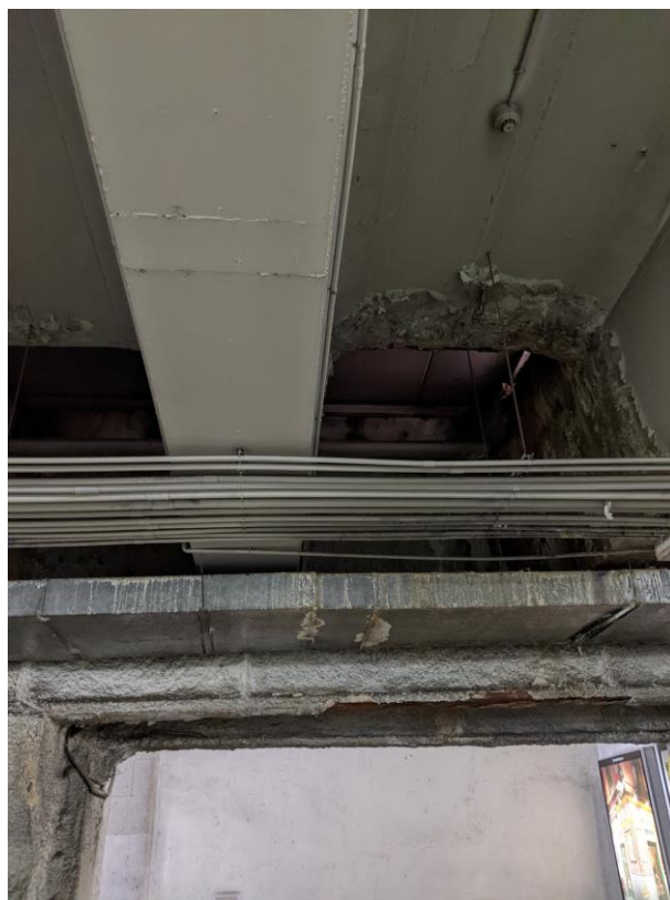
Foto 14. Humedades en forjado de cubierta, zona rampa (2)
