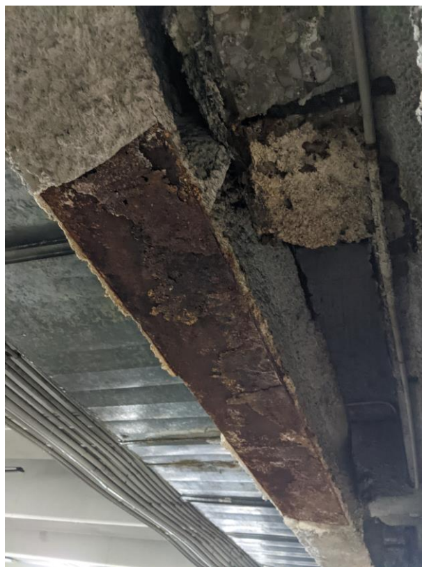
Foto 16. Estado del ala inferior de la viga dintel de la rampa de entrada
